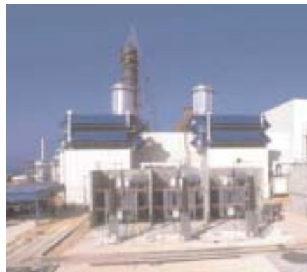
△ Centrale au gaz de El Beddaoui au Liban.
