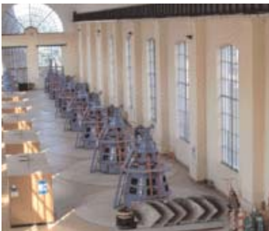
△ Centrale hydraulique de la Tuilière (Dordogne).
