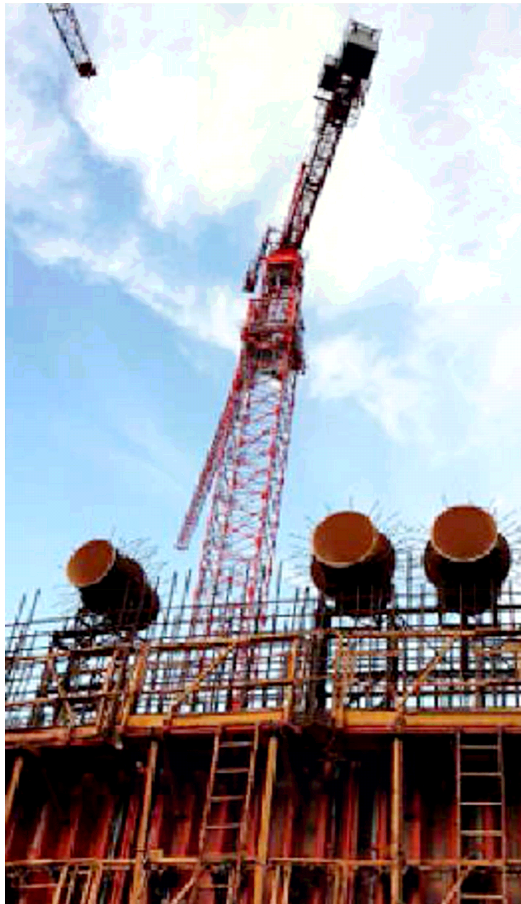
Pose de traversées de l'enceinte externe du bâtiment réacteur
