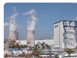
La centrale de Bugey 1 en déconstruction
