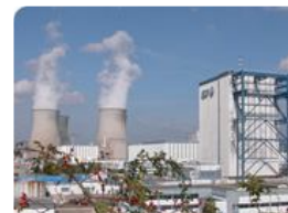
La centrale de Bugey 1 en déconstruction
