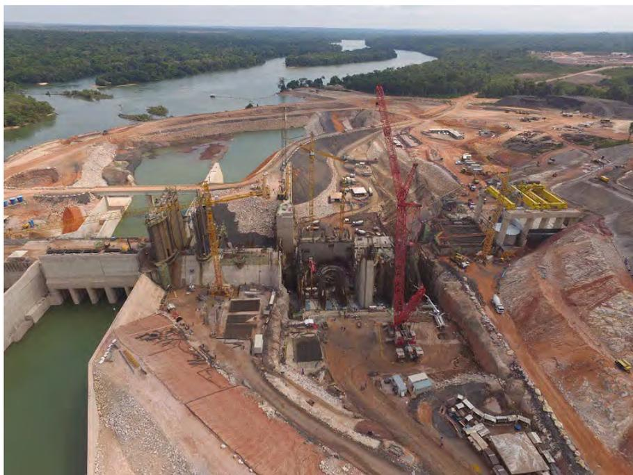
75 % des travaux de construction de l'ouvrage hydroélectrique de Sinop, au Brésil, ont été réalisés. Commencé en janvier 2014, cet aménagement fonctionnera avec deux groupes Kaplan de 202 MW chacun, turbines parmi les plus puissantes de ce type au monde. 2 400 personnes travaillent actuellement sur ce chantier
