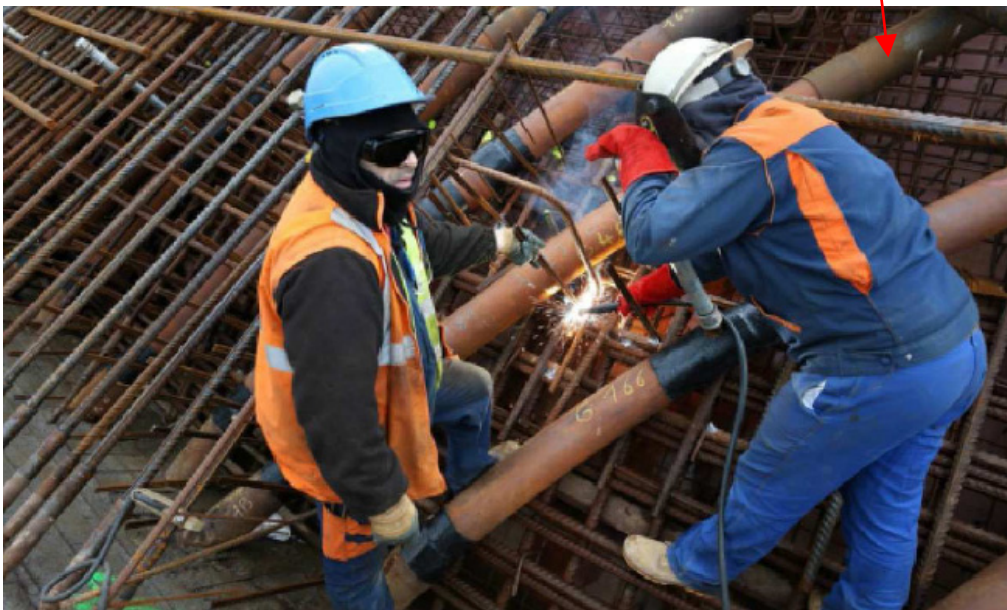
Bâtiment réacteur Le ferrailage de la levée n° 15 de l'enceinte interne a débuté sur le dôme
